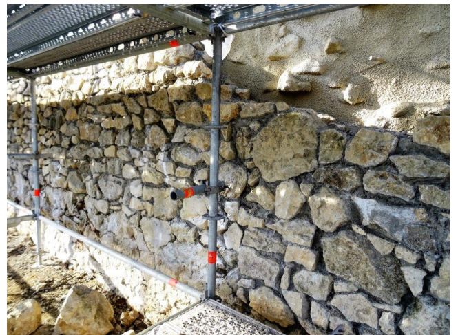
Hier wurde die Mauer bereits wieder repariert
