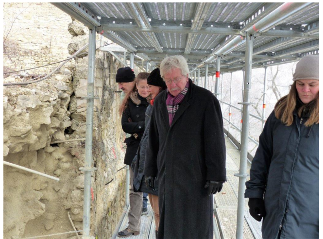
Prof. Dr. Goer nutzte den Besuch auf der Burg auch für eine Besichtigung der Baustelle und sparte nicht mit Lob für die denkmalgerechte Arbeitsausführung
