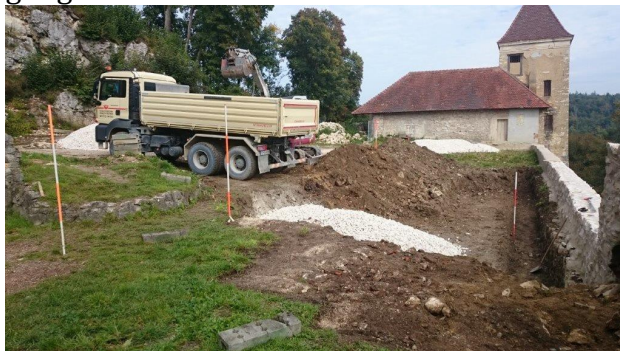
Auffüllen des Innenhofes
