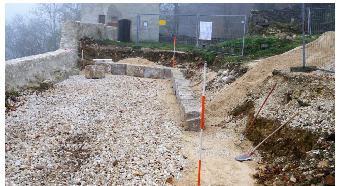
Die erste Reihe der Sitzsteine wird aufgebaut
