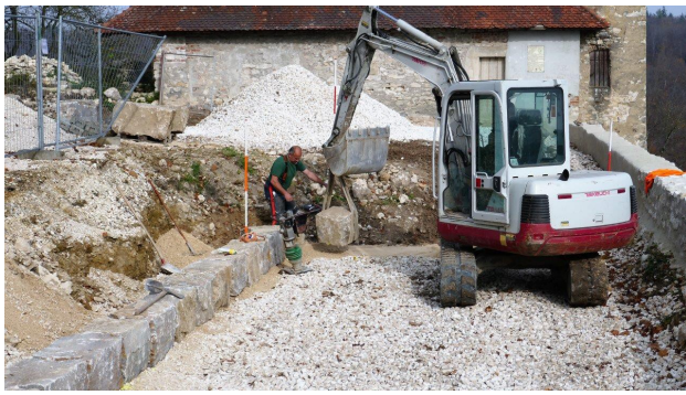
Rainer Prechtel bringt die Blöcke in Position
