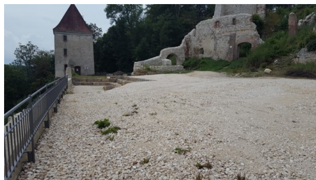
Das Gelände ist eingeebnet
