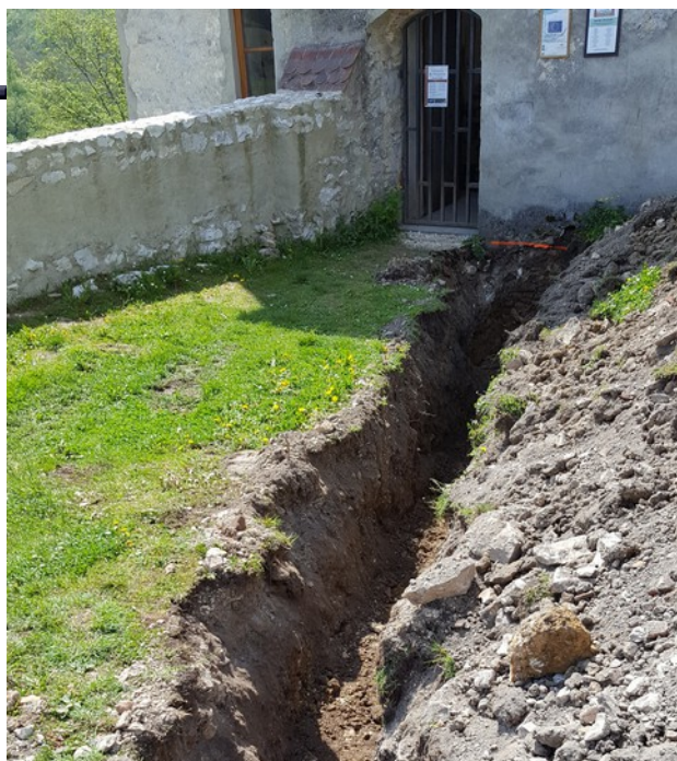
Graben vom Nord- zum Südturm für das Leerrohr
