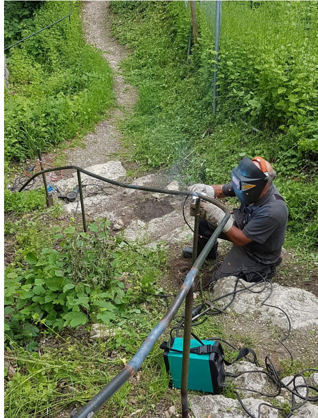
Schweißen des Treppengeländers
