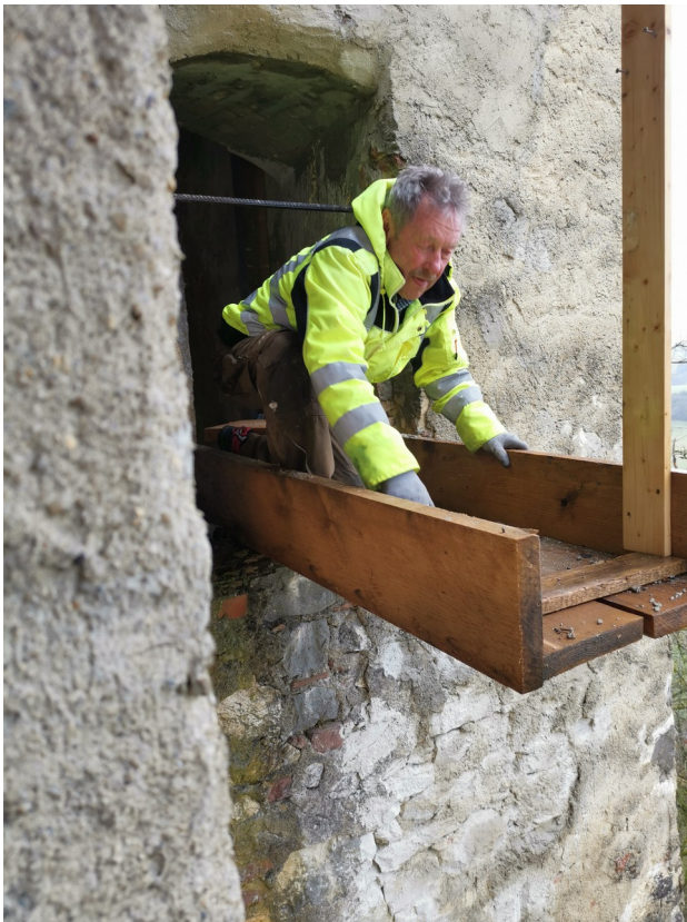
Robert Roth bei Ausbesserungen am Nordturm
