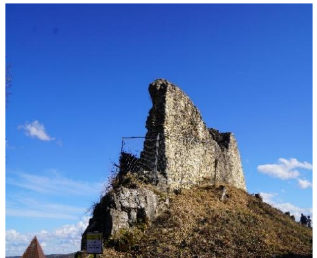
Mittlere Schildmauer, Nordansicht (03-2024 CS)
