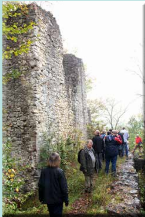
Das ist das „Korpus Delicti“, die eingestürzte Mauer zwischen Nord- und Süd- turm. Doch dies ist nicht die einzige Baustelle. Auch die beiden Türme benö- tigen an ihrem Fundament der Sanierung. Ein bautechnisches Gutachten, das in Auftrag gegeben werden soll, wird da Klarheit bringen und darlegen wie der langwierige Sanierungsweg am effektivsten gegangen werden kann.
