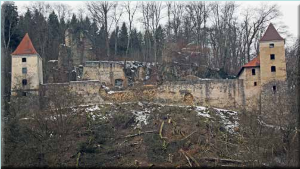
Das ist das „Korpus Delicti“, die eingestürzte Mauer zwischen Nord- und Süd- turm. Doch dies ist nicht die einzige Baustelle. Auch die beiden Türme benö- tigen an ihrem Fundament der Sanierung. Ein bautechnisches Gutachten, das in Auftrag gegeben werden soll, wird da Klarheit bringen und darlegen wie der langwierige Sanierungsweg am effektivsten gegangen werden kann.
